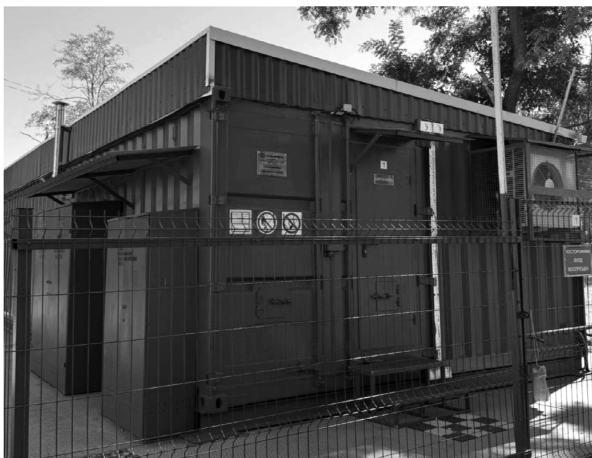
Fig. 9. Container version of the MHB «Edelweiss» Рис. 9. Вариант контейнерного исполнения МГБ «Эдельвейс»
